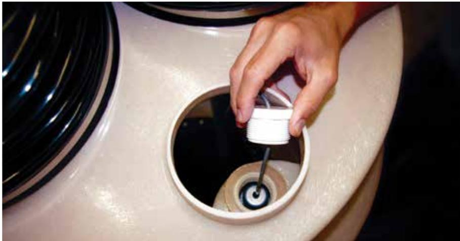
Pie de foto: El puerto de observación es un punto de acceso conveniente para inspeccionar el sensor de monitoreo en los modelos de sumidero de pared doble y realizar una inspección visual del interior del sumidero.
