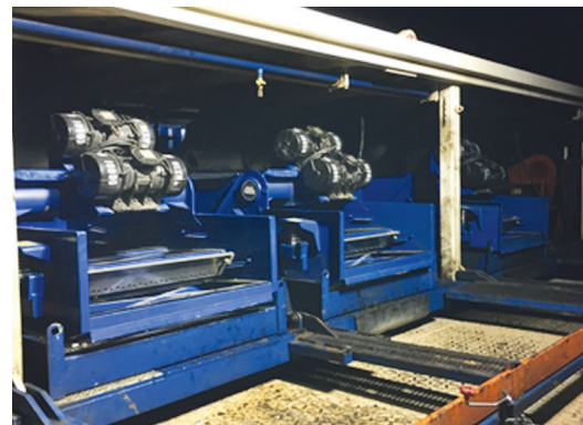
PENEIRA VIBRATÓRIA KING COBRA VENOM reinstalada.
