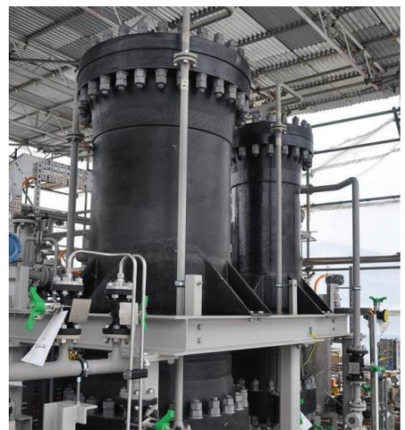
玻璃纤维系统先进的复合材料解决方案安装在BP Clair Ridge
